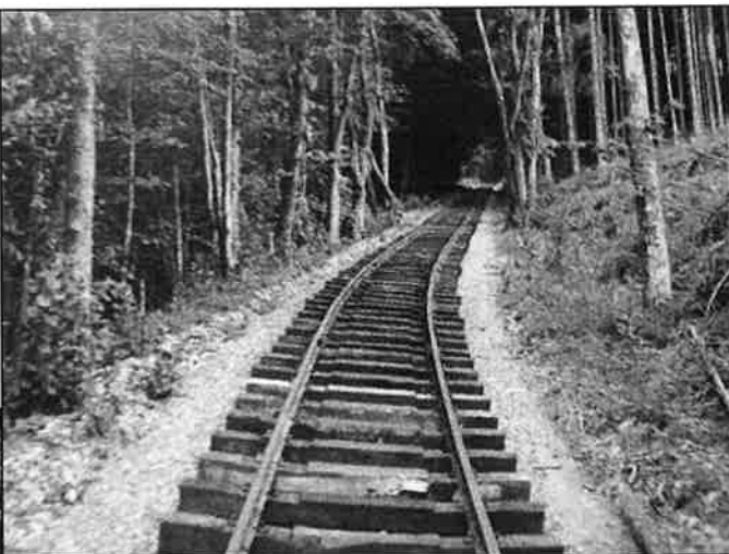
La voie fraîchement installée après l'arrêt de Dochamps. Photo TTA.
