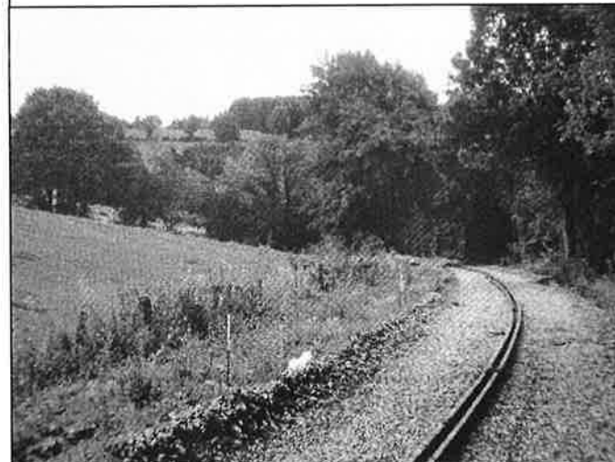
Essai de "monorail" ??? Non, ce sont les rails déposés en attente des traverses. Photo TTA.
